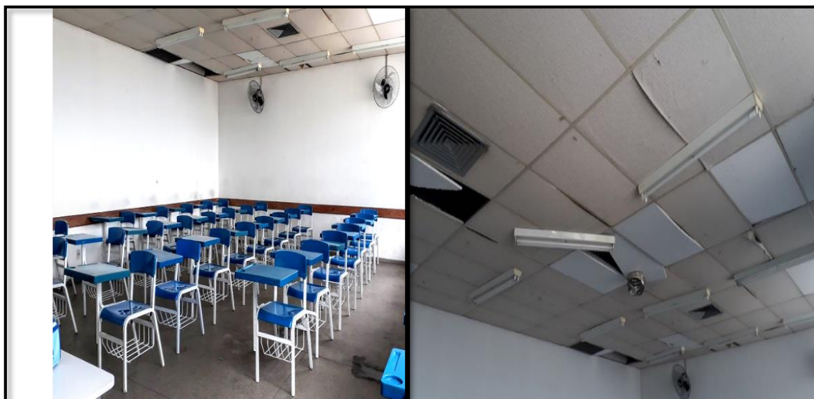
Figura 7 — Revestimento do teto da sala ambiente de Física
