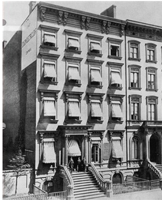
Figura 29: Fachada da Edson Electric Light Company. Fonte: Pagina Gettyimages. 19
