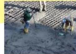
Em algumas obras de engenharia utiliza-se um aparelho chamado vibrador de concreto, cuja frequência coincide com a frequência natural de vibração da massa de concreto. A massa de concreto parece virar líquido durante o contato do aparelho com ela. Quando retiramos o vibrador da massa:
